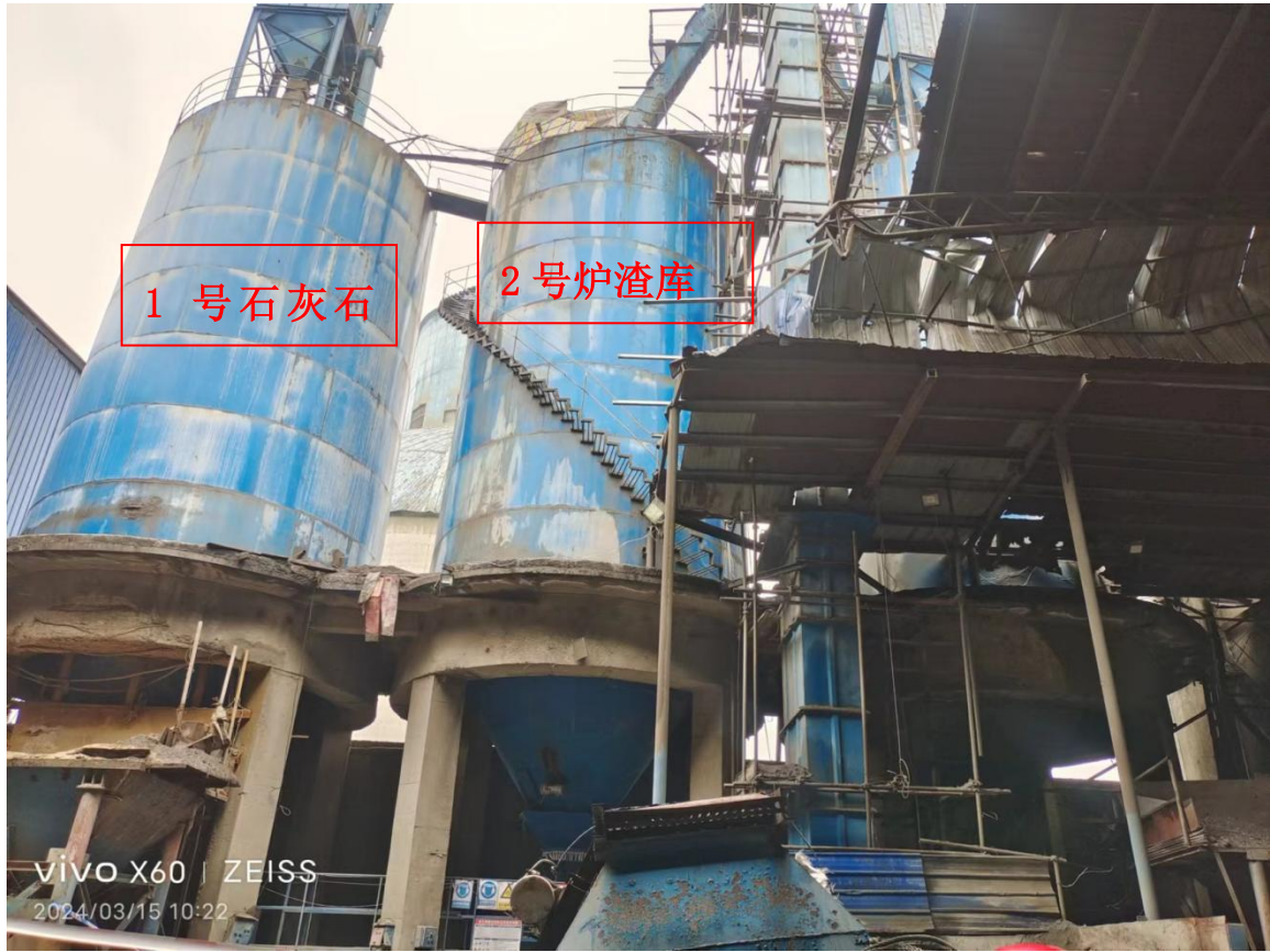
图 1 金山建材公司水泥车间 1 号石灰石库和 2 号炉渣库
