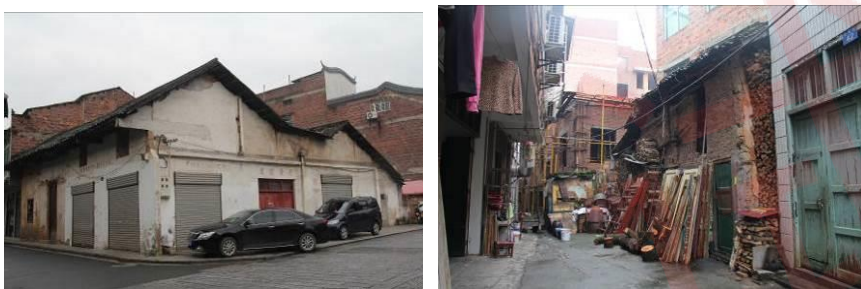
11-2 北支街内传统建筑
