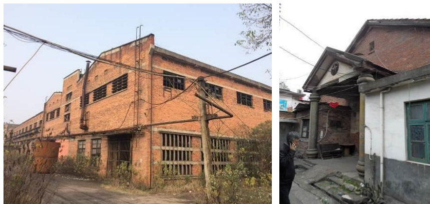
11-1 原建湘柴油机厂厂房及医院
