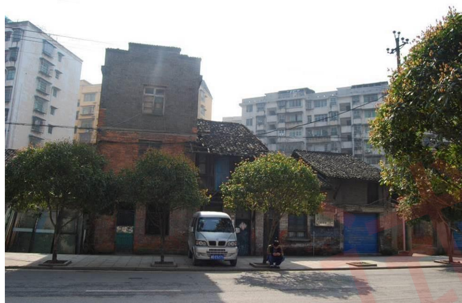
9-4 草后街地区的传统风貌建筑
