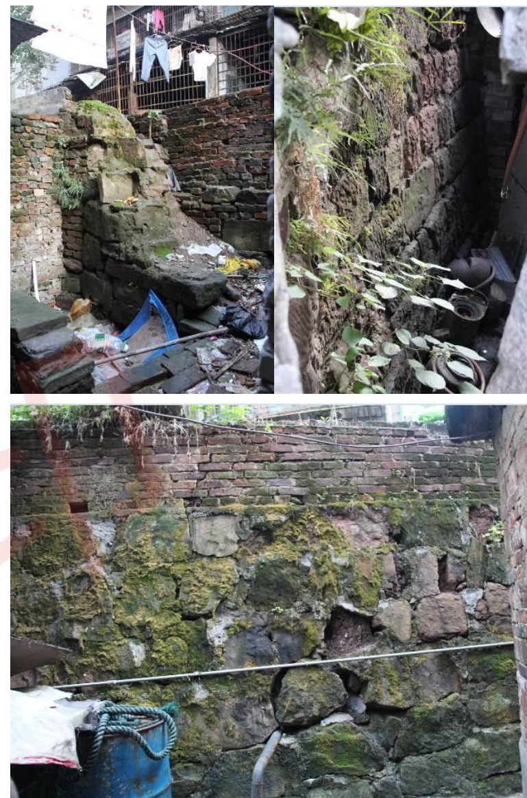
7-22 残存的的城墙遗址
